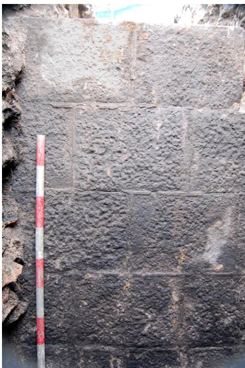
Foto 2. Detall de l'alçat de la muralla UE 101, es pot veure l'acabat dels carreus i l'encintat.
